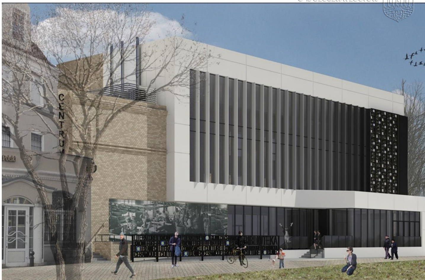
WIDOK ELEWACJI WSCHODNIEJ
