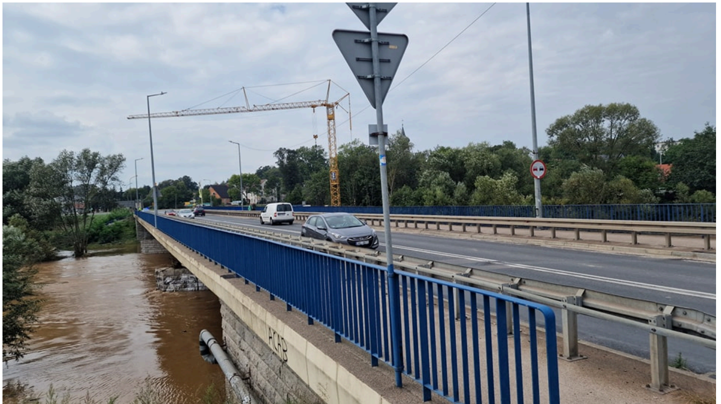
Most przy ul. Zgorzeleckiej otwarty dla pojazdów do 15 ton
